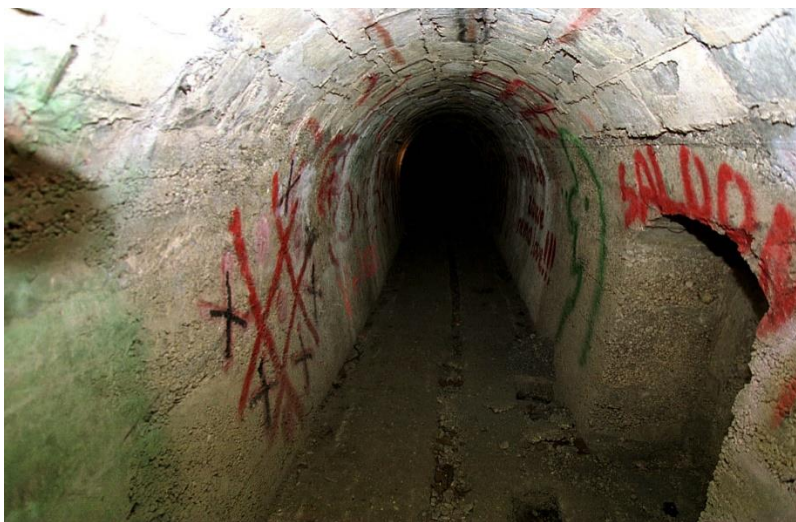
Slika 30. Izgled tunela vile Rebar
