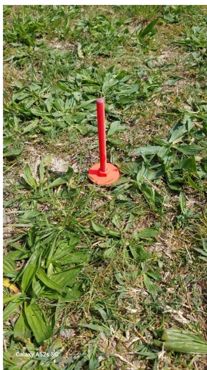
Slika 19. Metalni kolac za iskolčenje.
