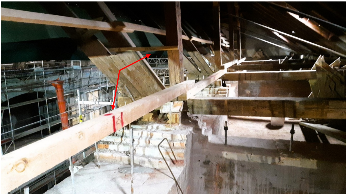
Slika 5.4. Pozicioniranje privremene nanosne skele
