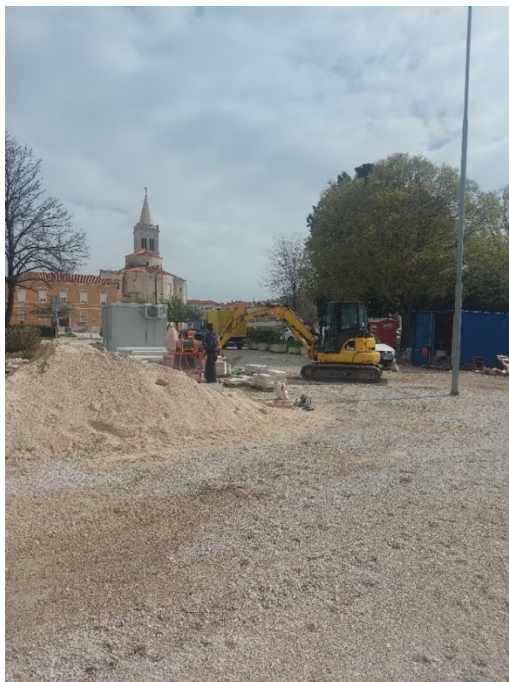
Slika 5.2. Radovi na gradskoj rivi, travanj
