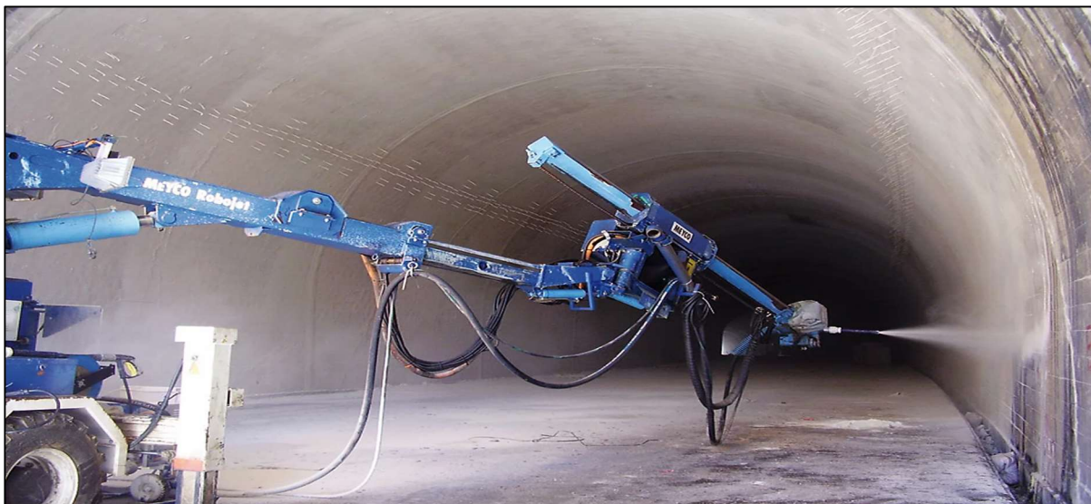
Slika 2.9. Postavljanje završne obloge tunela špricanim betonom (URL 7)
