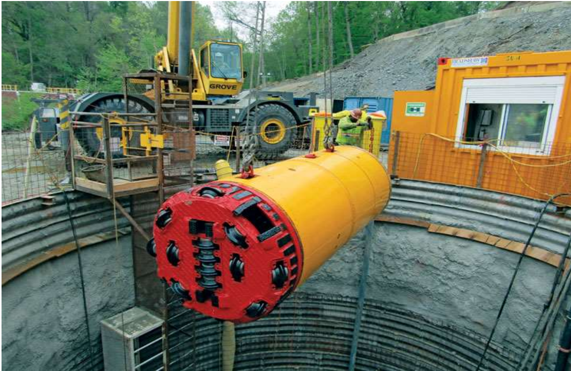
Slika 2.7. Spuštanje TBM-a u okno tunela (URL 6)
