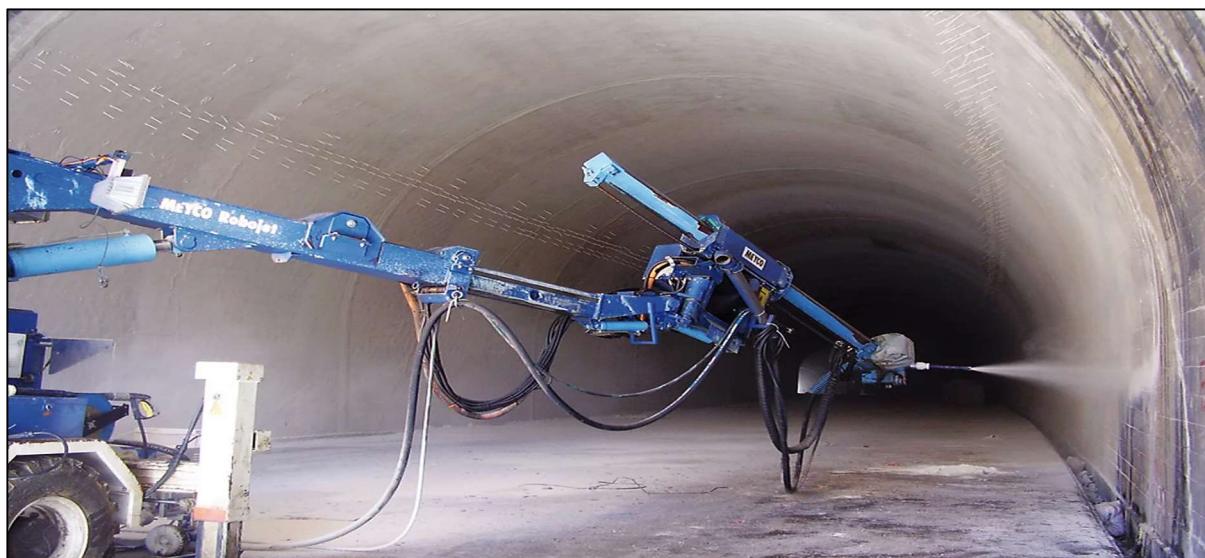
Slika 2.9. Postavljanje završne obloge tunela špricanim betonom (URL 7)
