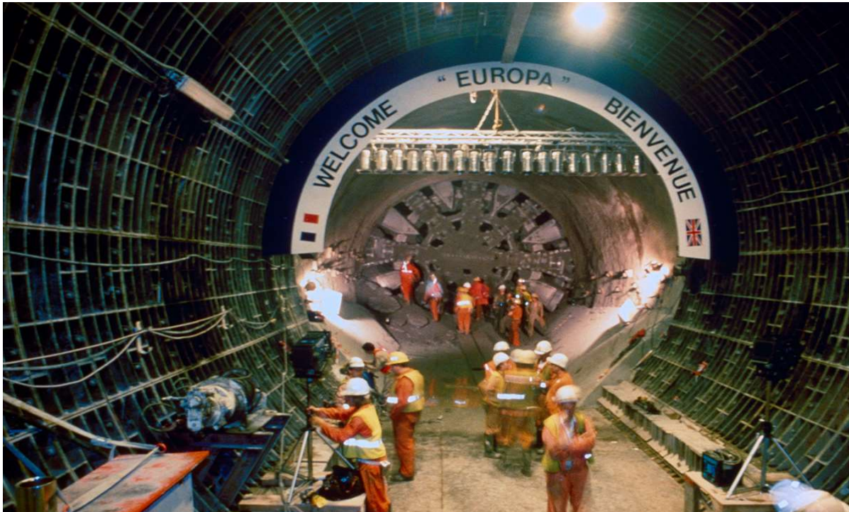
Slika 2.4. Proboj prve cijevi Channel Tunnel-a TBM-om (URL 3)
