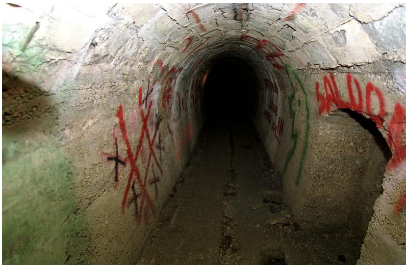
Slika 30. Izgled tunela vile Rebar
