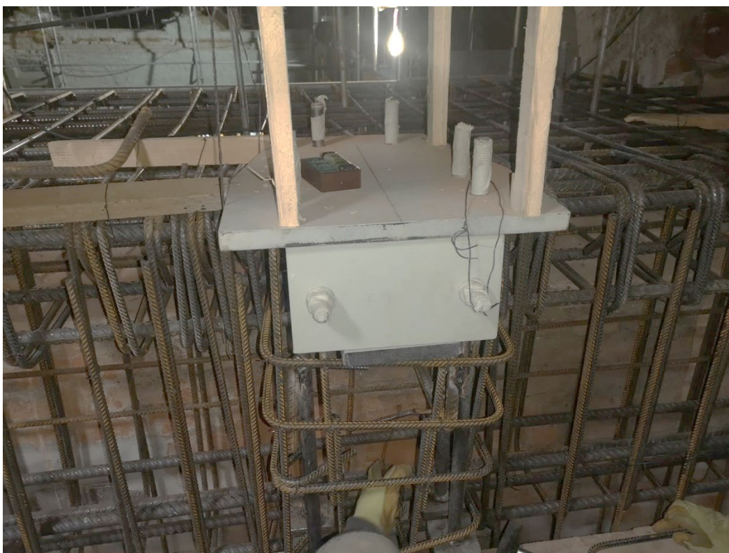
Slika 6.1. Postavljena anker ploča pozicija DSRI
