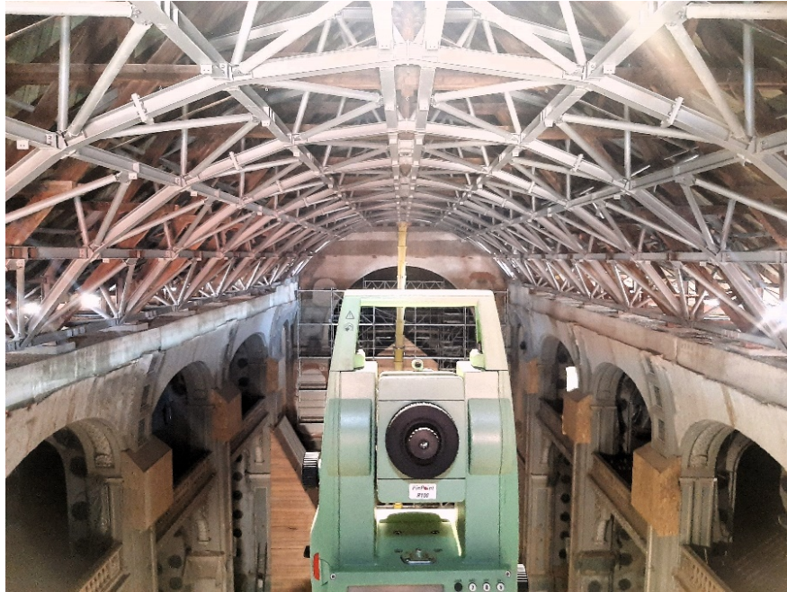
Slika 4.1. Izgled postavljene metalne konstrukcije svoda
