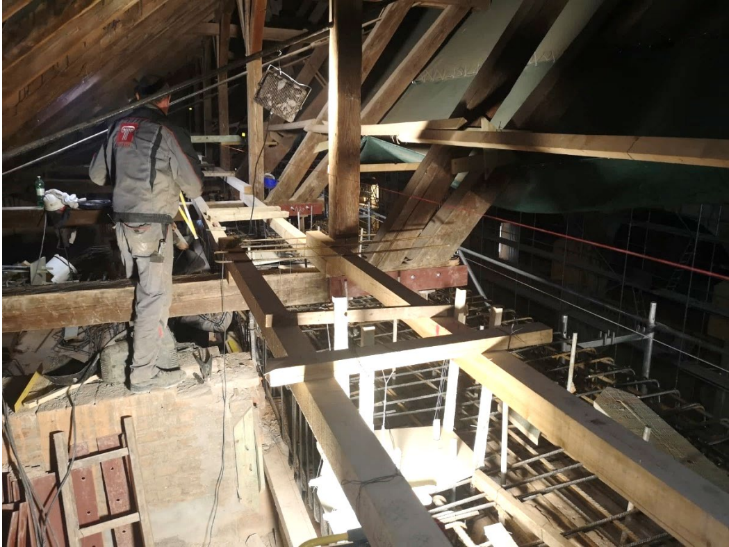
Slika 5.5. Nanosna skela anker ploča
