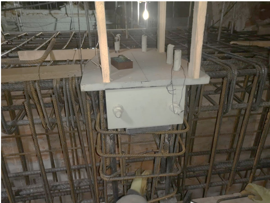
Slika 6.1. Postavljena anker ploča pozicija DSR1
