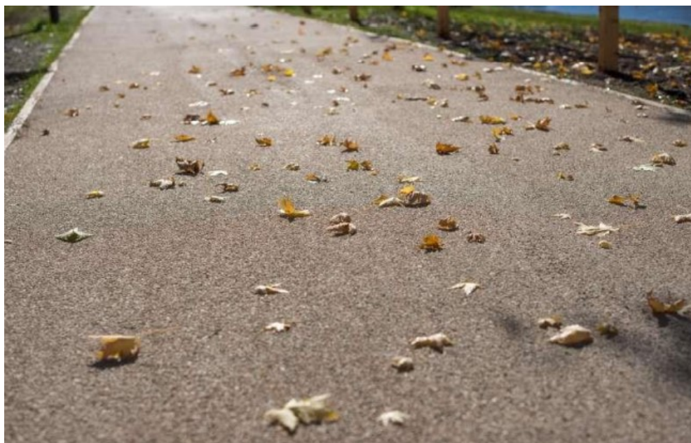
Slika 7.3. Primjer obloge od Stabilizer 2000.
