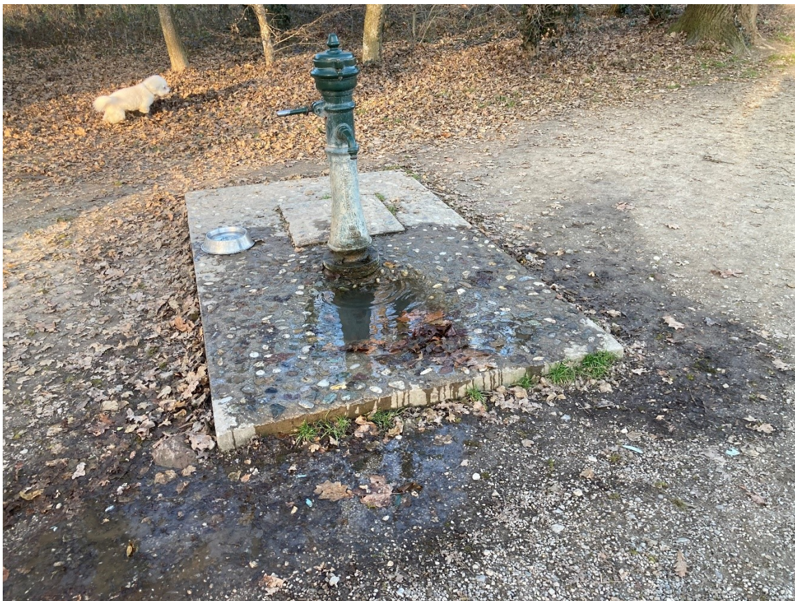
Slika 6.5 Otežani pristup pumpi za vodu
