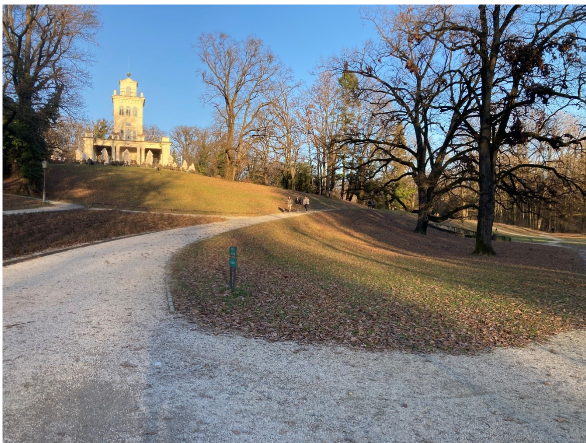
Slika 6.1. Pristup Vidikovcu – smjer pružanja staze zapad - istok.
