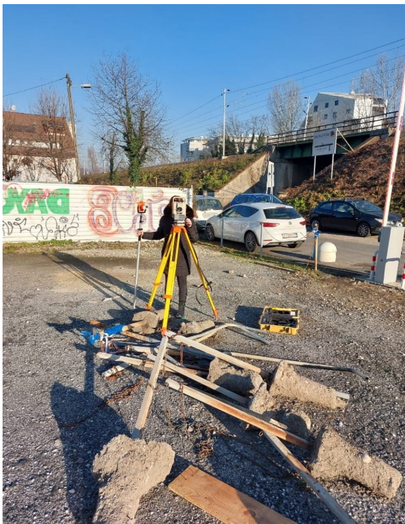
Slika 5.5 Izmjera terena mjernom stanicom
