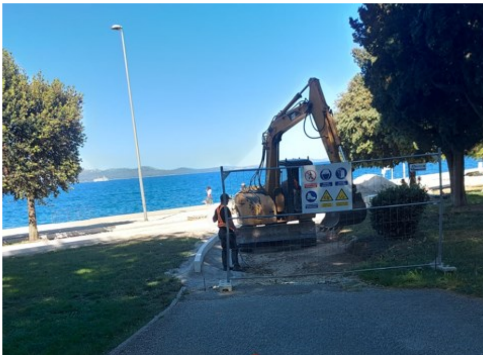
Slika 5.4. Radovi na rivi, svibanj
