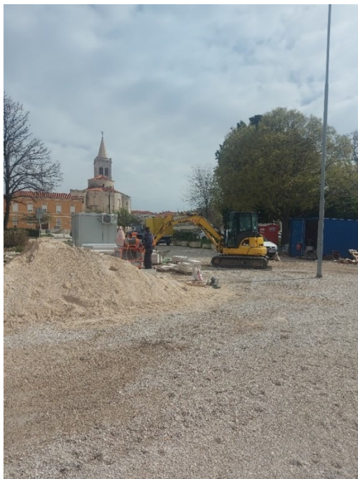
Slika 5.2. Radovi na gradskoj rivi, travanj
