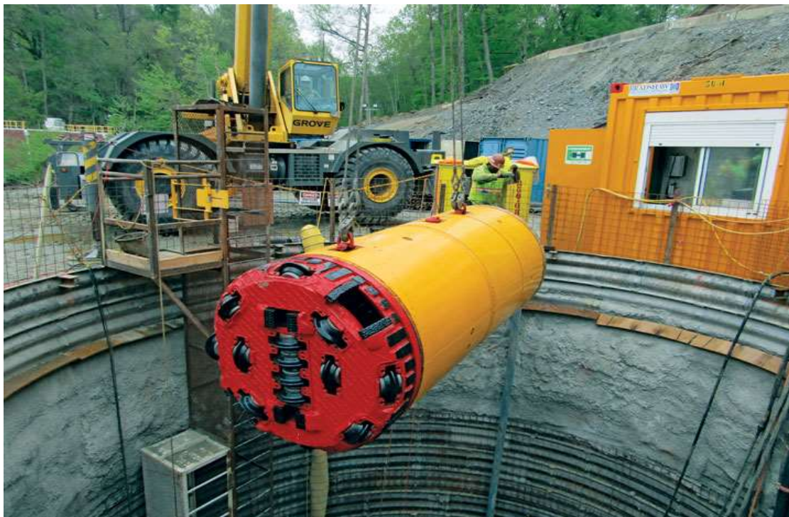
Slika 2.7. Spuštanje TBM-a u okno tunela (URL 6)
