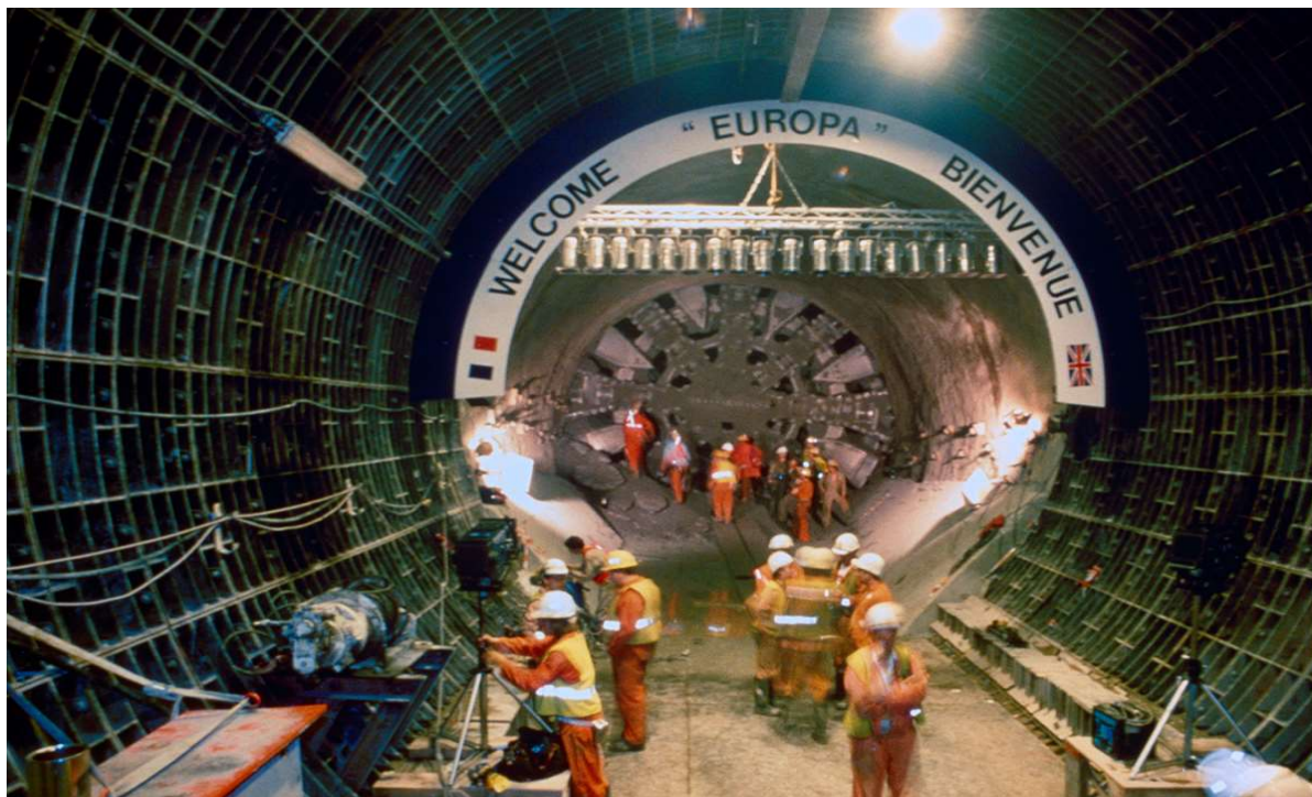
Slika 2.4. Proboj prve cijevi Channel Tunnel-a TBM-om (URL 3)
